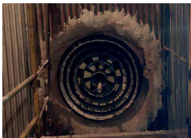
Рис. 9. Горелочные устройства в процессе изготовления ( а–в ) и после монтажа ( г )
