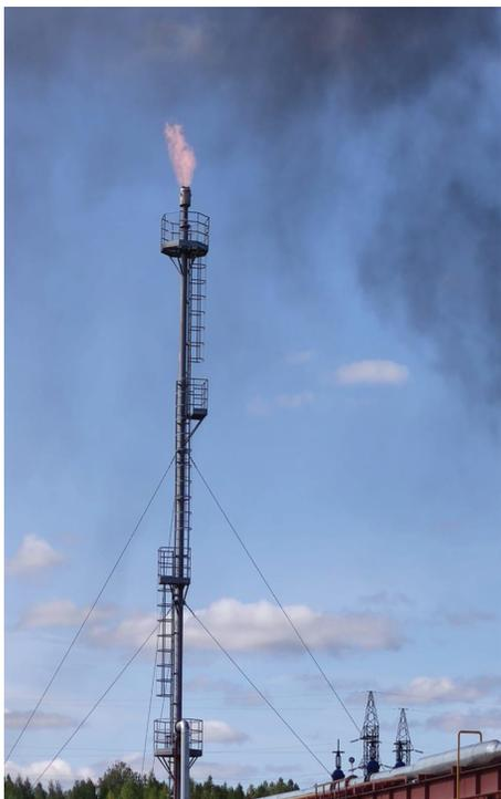
Рис. 8. Внешний вид факельной установки для сжигания синтез-газа
