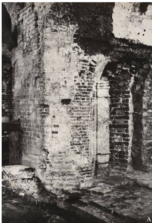
Рис. 2. А – Южный портал после раскрытия. Фото А.И. Петухова, 1957. Нег. ЦНРПМ № 2602. Б – Западный откос южного оконного проема после удаления штукатурки и частичного удаления перекладок. На фото видны система перевязки белокаменной и кирпичной кладок внешней и внутренней поверхности стены на уровне пяты крещатого свода. Фото А.И. Петухова, 1957. Нег. ЦНРПМ № 17472. В – Церковь Никиты Мученика. Южный портал после реставрации. Фото автора, 2021. Г – Внутренняя амбразура северного портала. Фото А.И. Петухова, 1957 г. Нег. ЦНРПМ № 17479.
