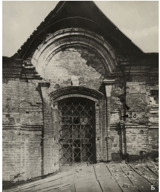
Рис. 4. А – Остатки отбutoчных рядов архивольтов кокошников на южном фасаде четверика древнего храма. Фото С.С. Подьяпольского, 1958 г. Нег. ЦНРПМ № 11775р. Б – Церковь Никиты Мученика. Западный фасад. Лопатки плечиками. Кладка около 1595 г. Фото С.С. Подьяпольского.
