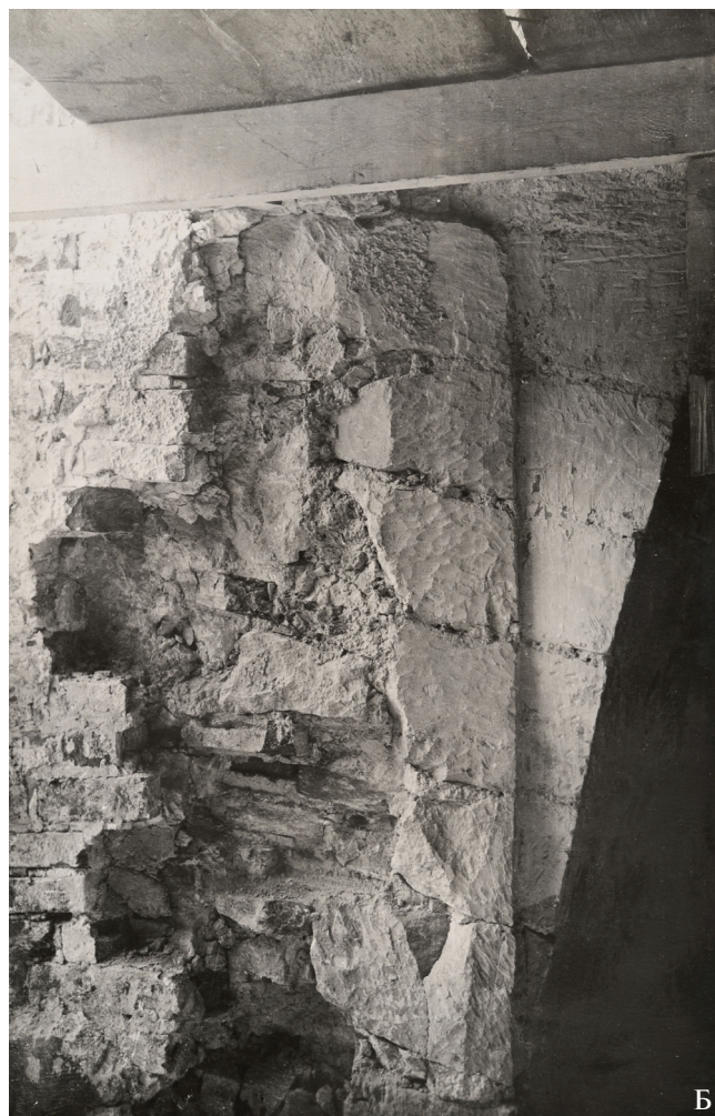
Рис. 2. А – Южный портал после раскрытия. Фото А.И. Петухова, 1957. Нег. ЦНРПМ № 2602. Б – Западный откос южного оконного проема после удаления штукатурки и частичного удаления перекладок. На фото видны система перевязки белокаменной и кирпичной кладок внешней и внутренней поверхности стены на уровне пяты крещатого свода. Фото А.И. Петухова, 1957. Нег. ЦНРПМ № 17472. В – Церковь Никиты Мученика. Южный портал после реставрации. Фото автора, 2021. Г – Внутренняя амбразура северного портала. Фото А.И. Петухова, 1957 г. Нег. ЦНРПМ № 17479.
