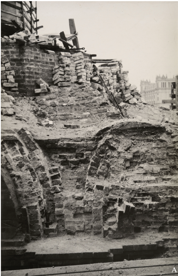
Рис. 4. А – Остатки отбutoчных рядов архивольтов кокошников на южном фасаде четверика древнего храма. Фото С.С. Подьяпольского, 1958 г. Нег. ЦНРПМ № 11775р. Б – Церковь Никиты Мученика. Западный фасад. Лопатки плечиками. Кладка около 1595 г. Фото С.С. Подьяпольского.
