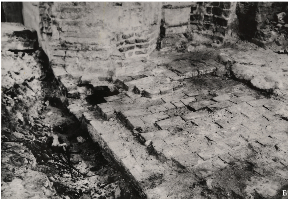
Рис. 1. А – Церковь Никиты Мученика. Подклет. Восточная часть северной стены. Фото А.И. Петухова, 1957. Б – Выстилка из маломерного кирпича в основании южного портала церкви Никиты Мученика. Фото А. Петухова, 1957. Нег. ЦНРПМ 2598р.
