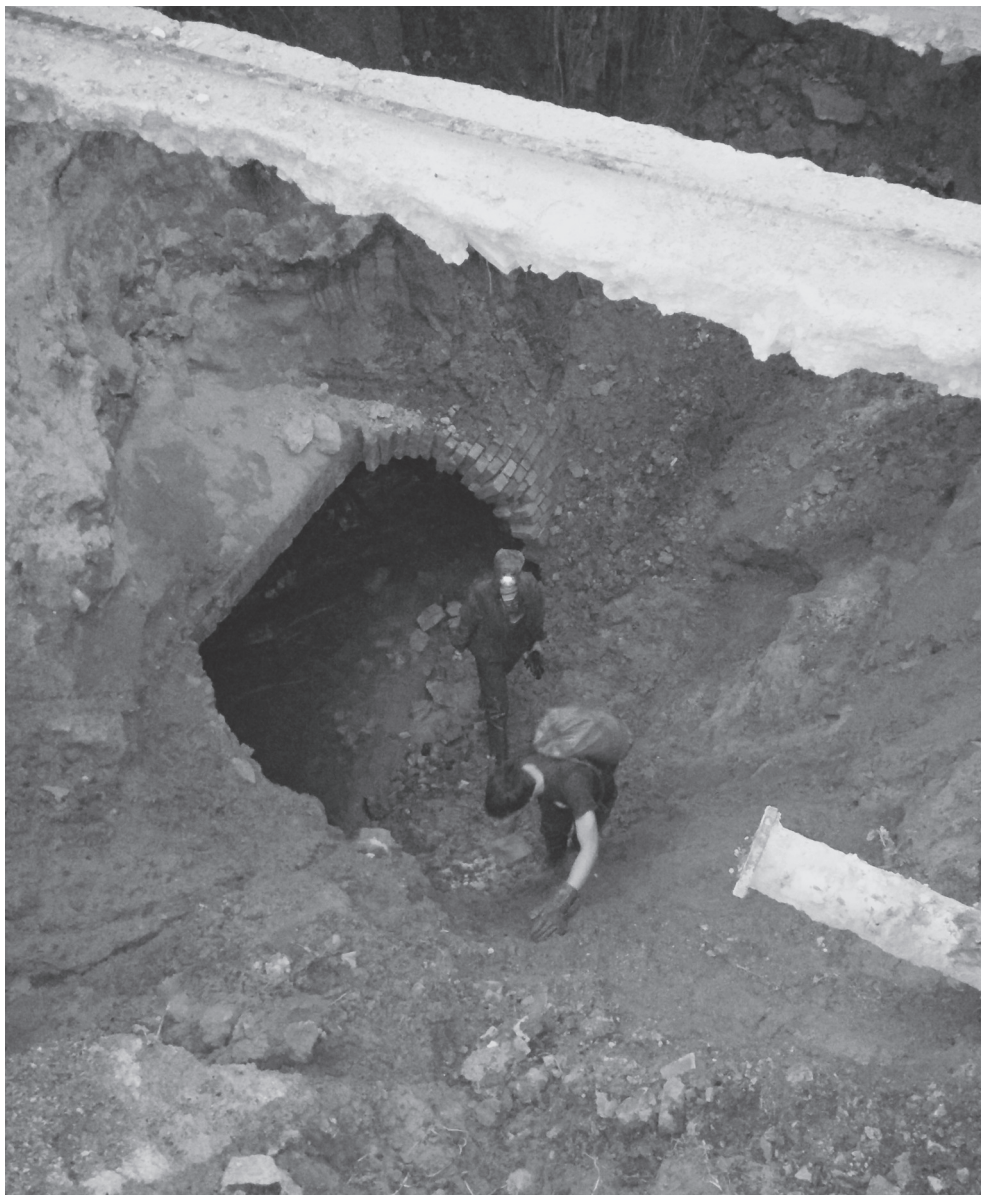
Рис. 2. Провал глубиной около 10 м на месте разрушения коллектора р. Сырец в Киеве в 2014 г. Фото Н.В. Коробко.
