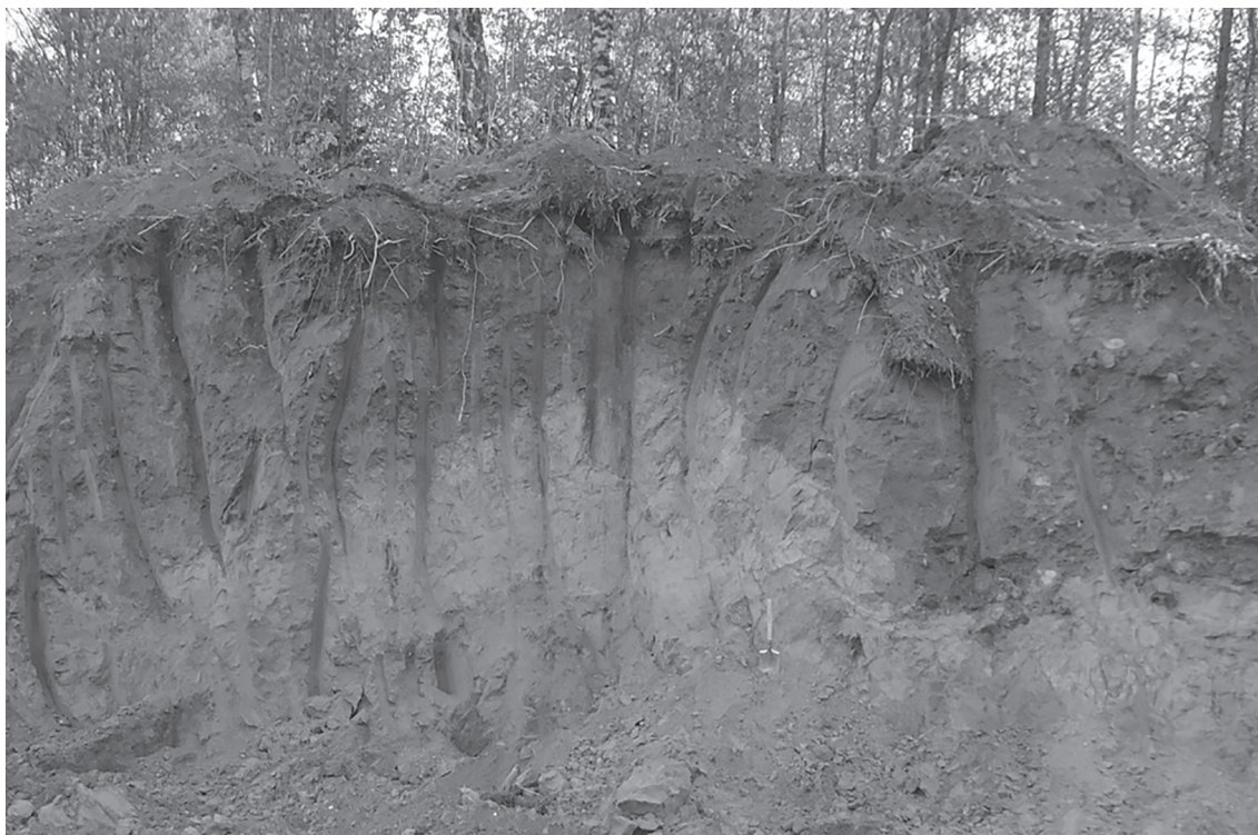
Рис. 4. Обнажение 1796. В правой части виден сброс амплитудой 1.6 м, сместитель падает на северо-запад под углом 44°.
