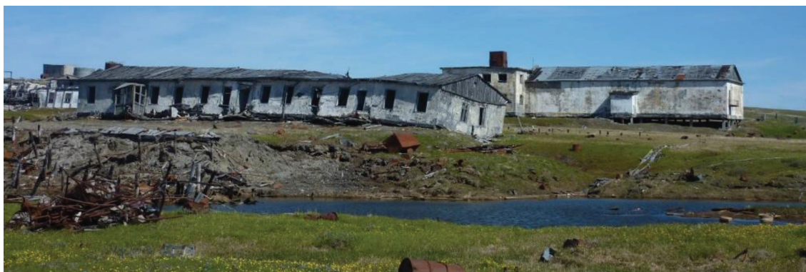
Рис. 7. Развитие термокарста вблизи здания в поселке Амдерма (фото Ю.В. Черняк, 2021).
