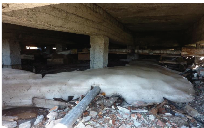
Рис. 6. Наличие воды (льда) в подполье каменного здания (фото Ю.В. Черняк, 2021).
