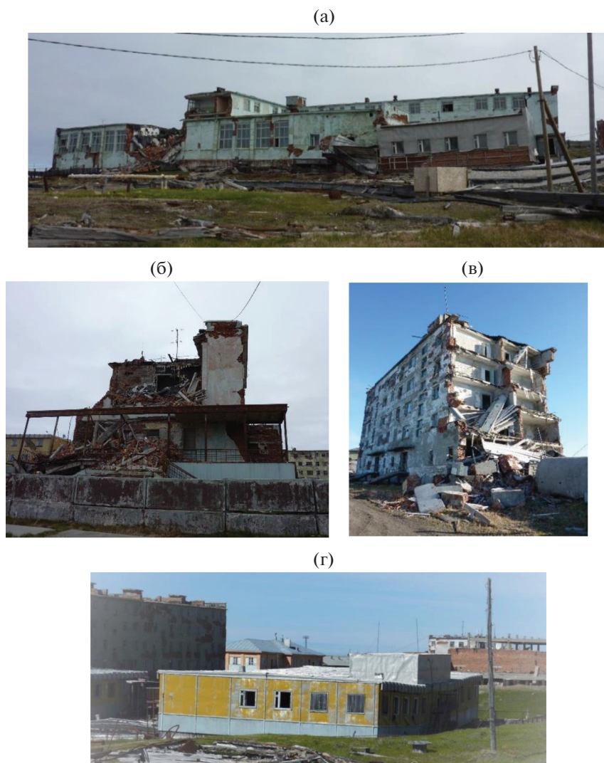
Рис. 4. Школа (а), дом офицеров (б), жилое 5-этажное здание (в) и детский сад “Арктик Строй” в пос. Амдерма (г) (фото Ю.В. Черняк, 2021).
