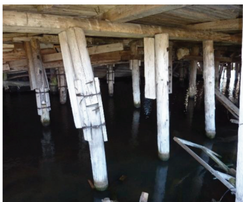
Рис. 6. Наличие воды (льда) в подполье каменного здания (фото Ю.В. Черняк, 2021).
