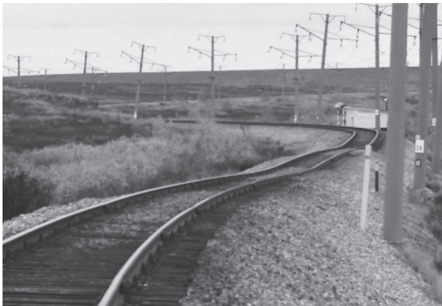
Рис. 1. Серия малоамплитудных просадок первого типа, сформировавшихся предположительно в результате неравномерного оттаивания льдистых грунтов (2022 г.).
