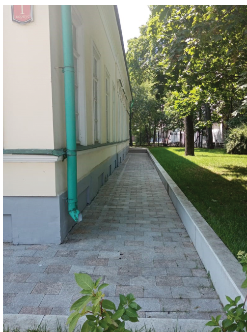
Рис. 5. Фотофиксация дворовых фасадов и территорий, прилегающих к “Дому Протковой” (ОКН – Садово-Кудринская, 15). Водостоки. Трещины на фасадах.
