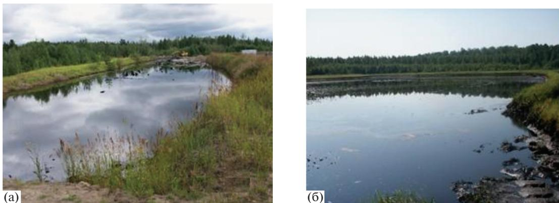
**Рис 3.** Амбар (а) и искусственно созданный карьер (б) для хранения аварийно собранной нефтесодержащей жидкости (фото из личного архива автора).
