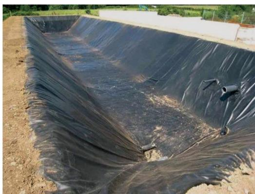
**Рис. 4.** Гидроизоляция амбара, предназначенного для сбора нефтесодержащей жидкости (фото взято из открытых источников).
