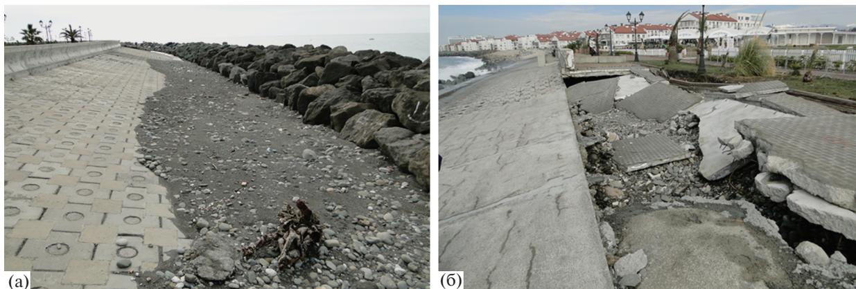
Рис. 5. Защита набережной олимпийского комплекса в Адлере наброской крупного камня (а) и ее разрушение (б).
