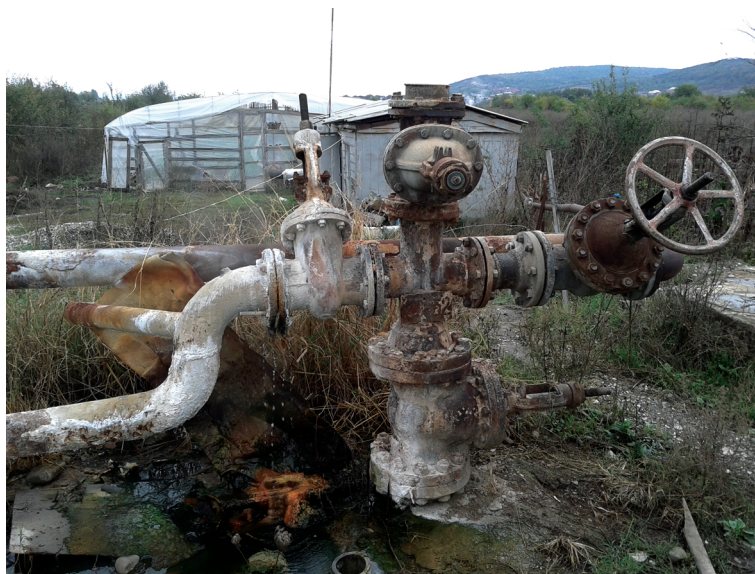
Рис. 1. Влияние минерализации теплоэнергетических вод на оборудование геотермальной станции. Скважина № 27–32 Ханкальского месторождения, Чеченская Республика.
