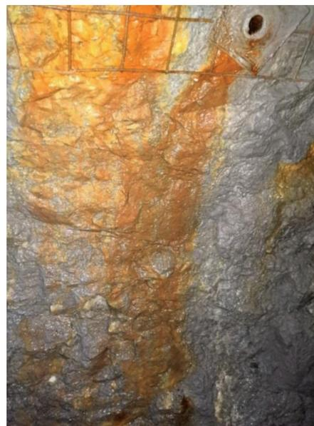
Рис. 3. Концентрация стока анкером крепления при трещинно-поровой проницаемости пород.
