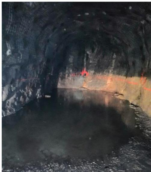
Рис. 6. Разгрузка подмерзлотных вод на горизонте +0 м (Северный участок месторождения “Купол”).
