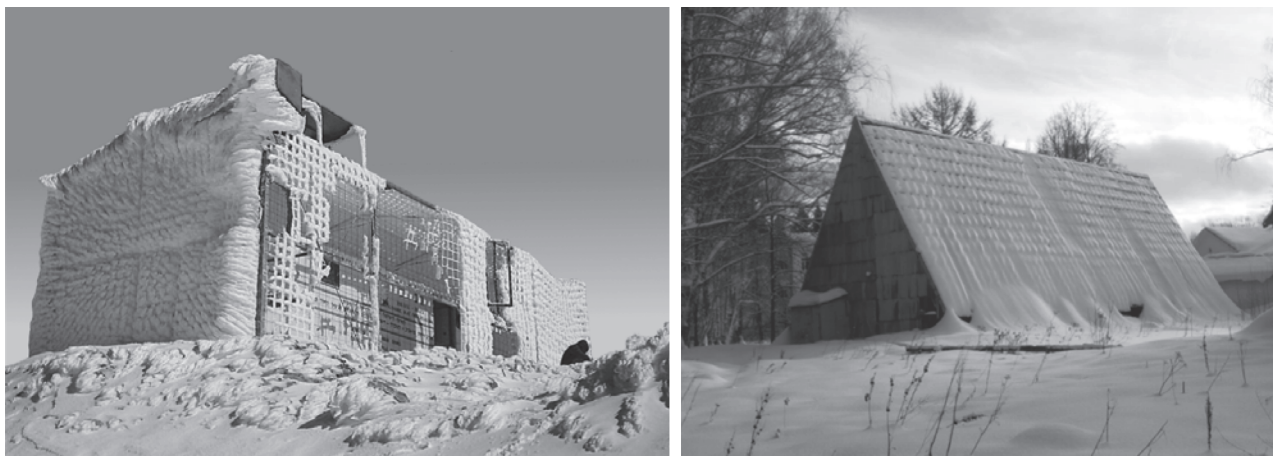
Рис. 1. Накопление снега: слева – вокруг клетки Фарадея на станции космических лучей ESOI (Голанские высоты) [Dorman et al., 2003], справа – на шатровой крыше и вокруг ст. Москва.
