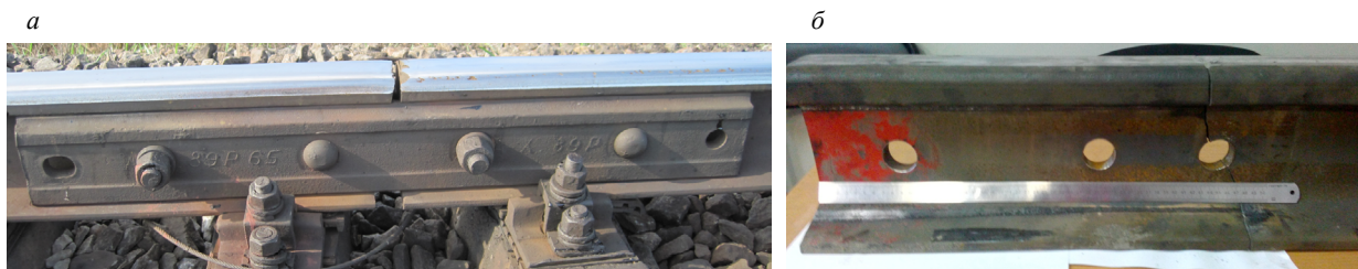
Рис. 1. Болтовой стык рельсов в шестидырных накладках (а); на концах стыкуемых рельсов имеются по три болтовых отверстия (б).
